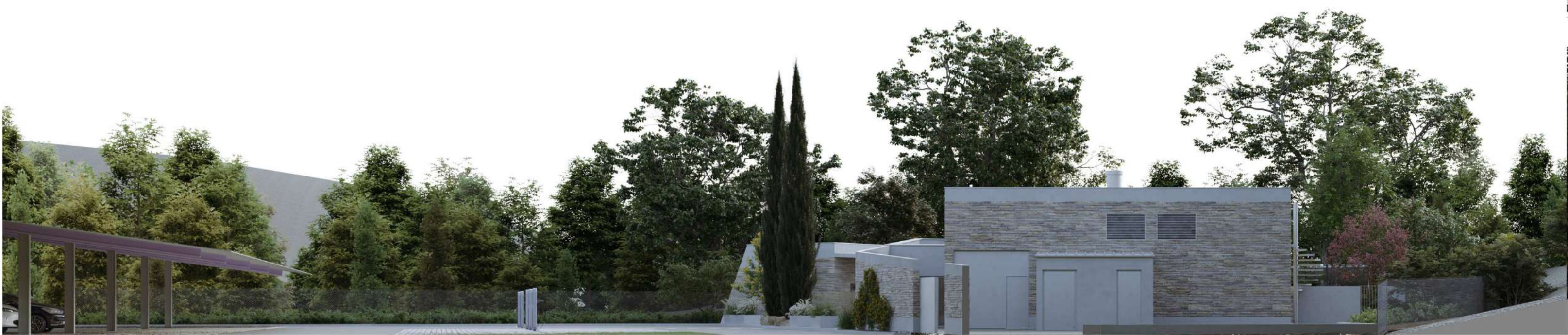
PIGNON OUEST (COUR TECHNIQUE)
