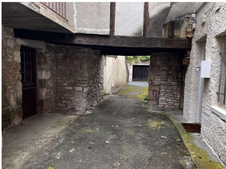
Le porche surplombant la rue est constitué d'une structure mixant des éléments en bois et des éléments de maçonnerie. L'ensemble est couvert par une même toiture.
